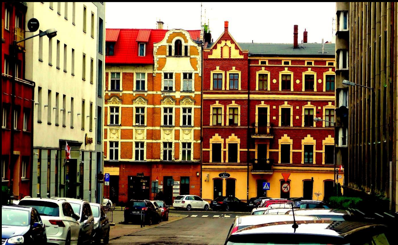
Ulica Podchorążych, a całkiem w tyle ulica Powstańców.
