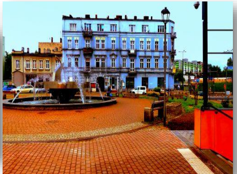
W tyle stojący przy ulicy Dęblińskiej budynek nr 1
