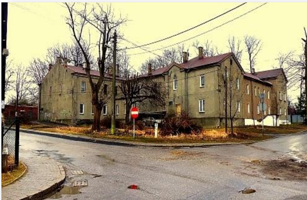
Powyższe cztery zdjęcia autora z 29 marca 2018 roku. Budynek dawnego Warszawskiego Towarzystwa Kopalń Węgla i Zakładów Hutniczych.
