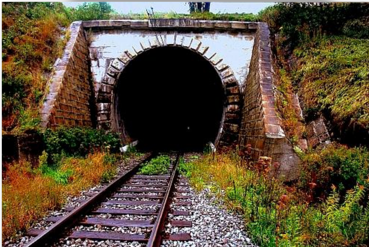
Dwa górne zdjęcia autora z 2007 roku. Lewy wlot do tunelu jabłnkowskiego od strony południkowej.
