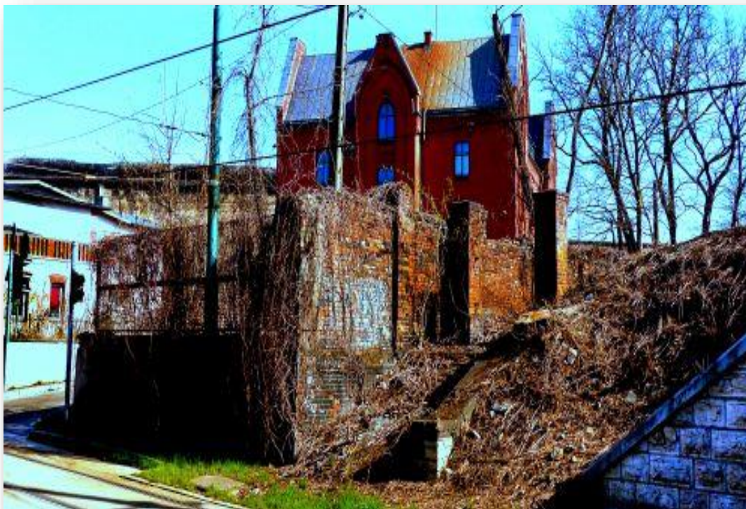
Zdjęcie górne z 2019 roku. Po prawej stronie, tuż obok wapiennych murów z wiaduktu kolejowego widoczne są jeszcze ocalałe od wyburzenia murki oporowe, jakie w 1902 roku wraz ze schodami wiodły z platformy peronowej aż do chodnika przy ówczesnej ulicy Dytłowskaja (obecna ul. Stefana Żeromskiego).
