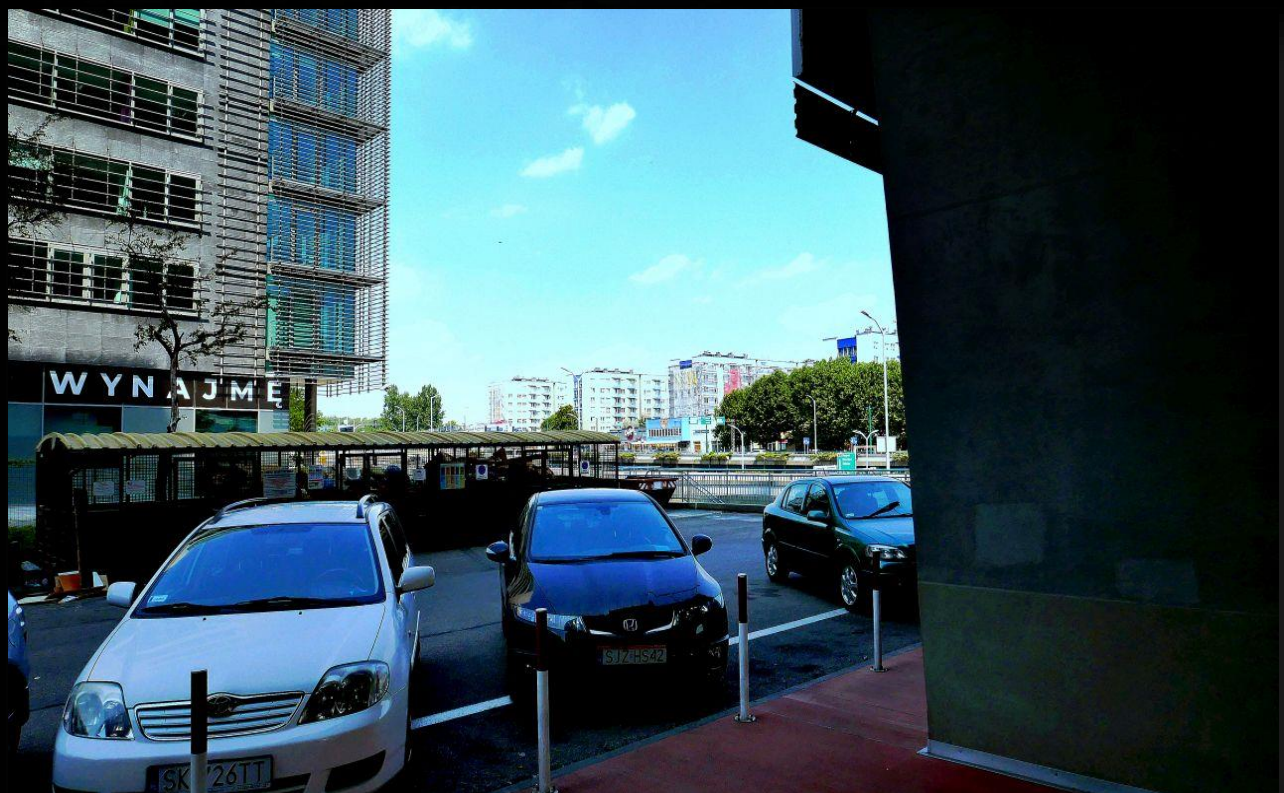
Zdjęcie utrwalone spod potężnych filarów , na której stoi „Superjednostka”. W oddali tak zwane niebieskie bloki na Koszutce.
