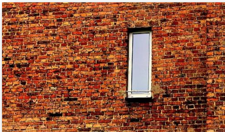
Zdjęcia z 8 października 2016 r. Po prawej wąziutkie okienko z przedpokoju – dawnej „meliny” w budynku nr 5.
