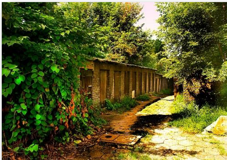
Zdjęcie z 2007r. „Wenecja”. Po prawej fragment budynku nr 2, a po lewej stronie ukryte w krzakach komórki należące do lokatorów zamieszkujących w tym budynku.
